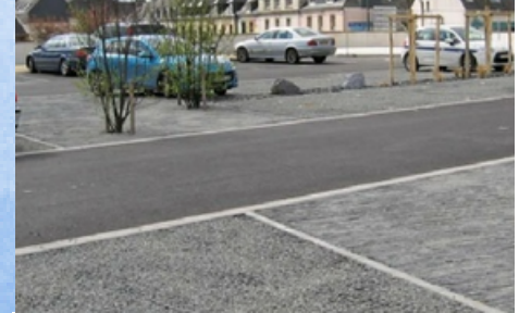
PARKING ET VOIRIE Parking en concassé Voirie en enrobé
